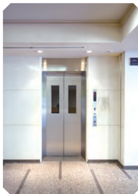
エレベーター
